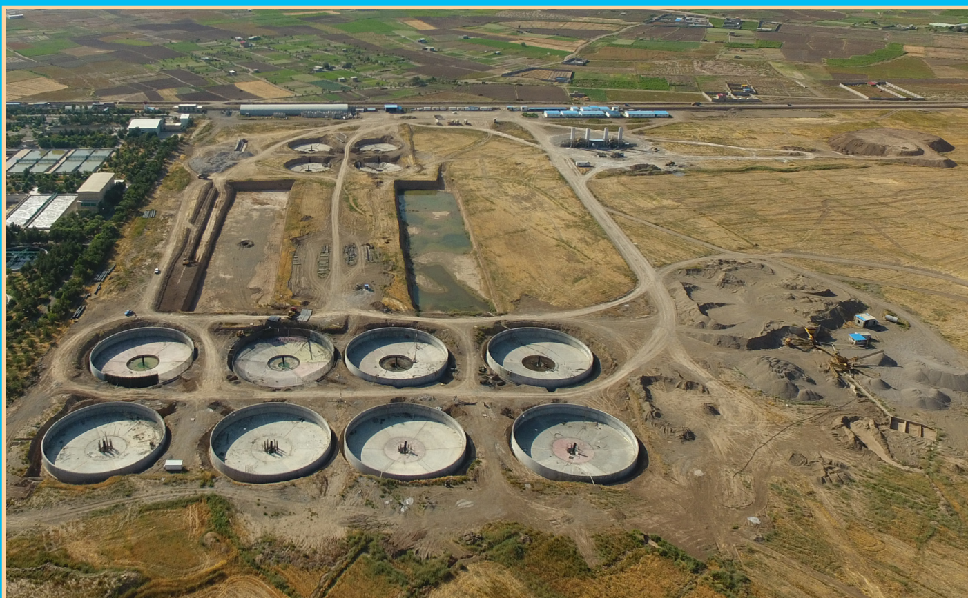
مدول دوم تصفیه خانه فاضلاب کلانشهر تبریز (در حال احداث)
